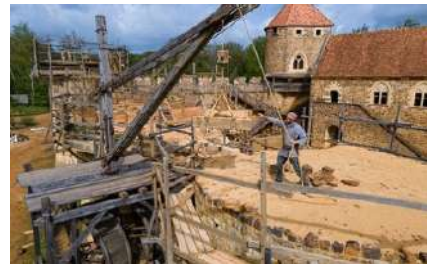
Le chantier médiéval du château de Guédelon, un site unique au monde www.guedelon.fr
